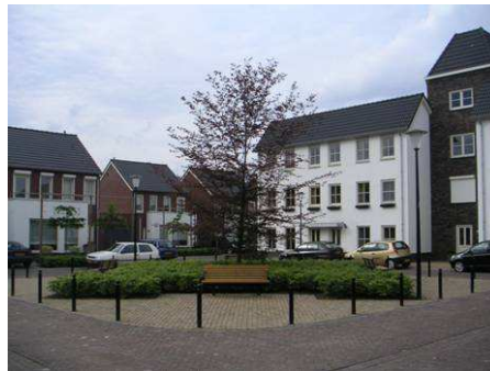
Nieuwbouw flankeert de oude mouttoren aan de Brouwerij Maeshof
