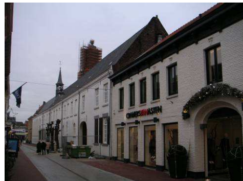
Noordzijde Maasstraat ter hoogte van klooster
