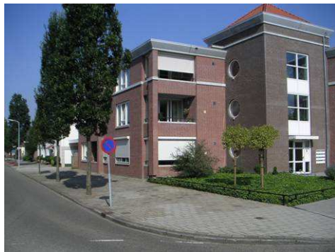
Nieuwbouw hoek Victor de Stuersstraat
