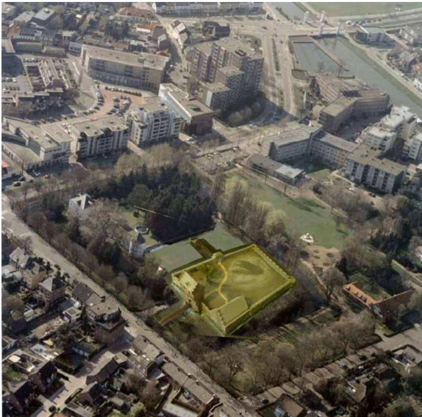
afb. 6 de ruimte op de belangrijkste erfgoedlocatie van Weert in optima forma. Het historisch ensemble rond het kasteel met: 1) hoofdburcht 2) voorburcht 3) tiendschuur
